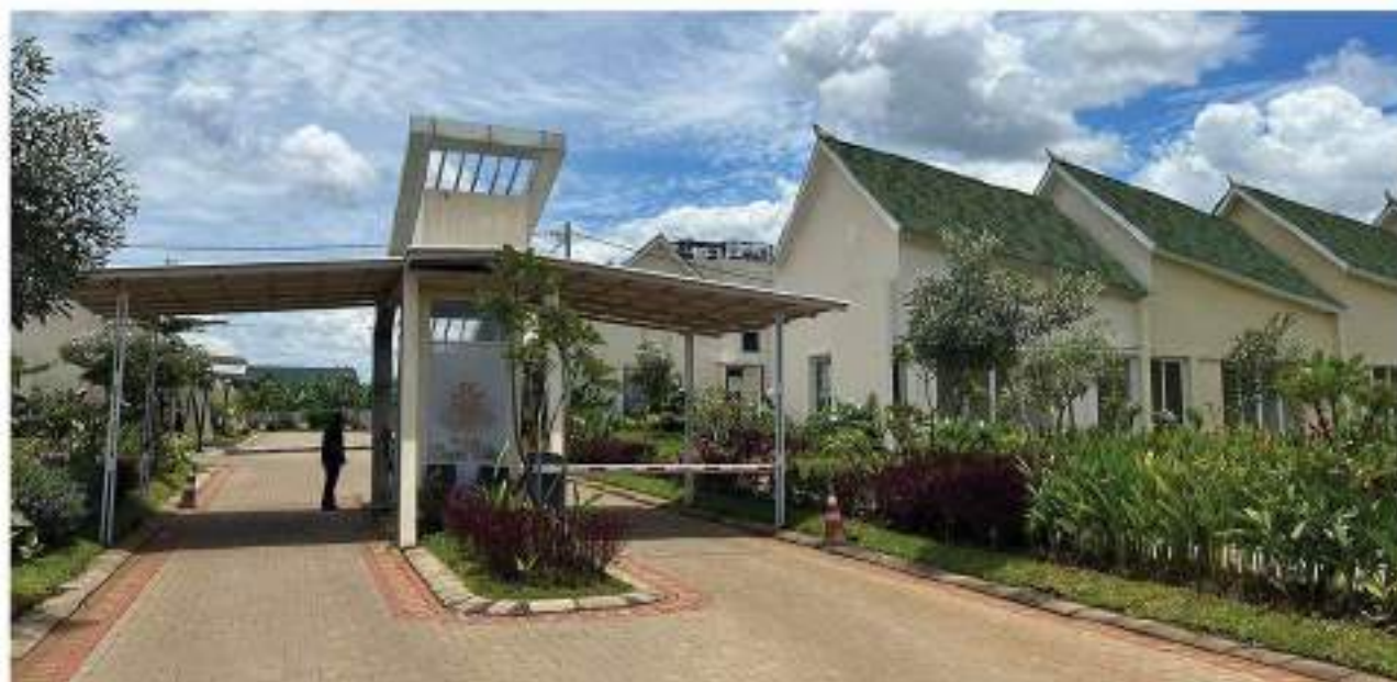
Pintu masuk / Entrance
